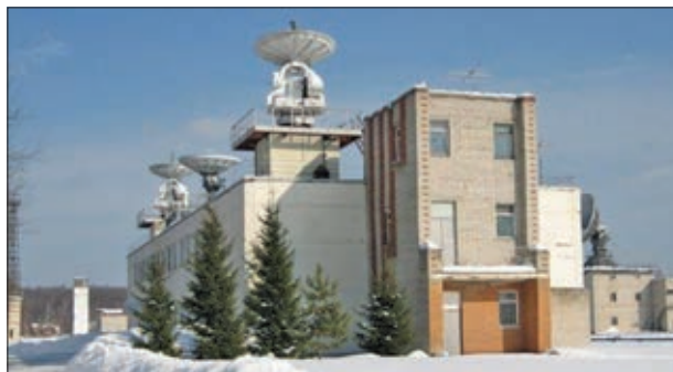
Рис. 4. Центральний синхронізатор, м. Щолково
